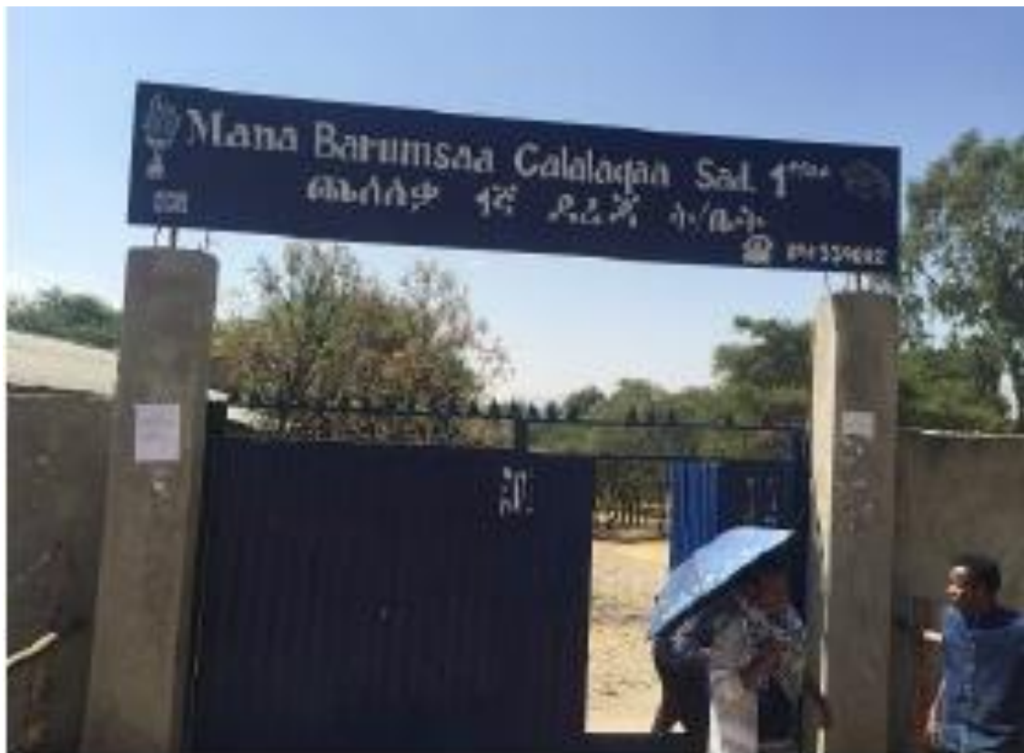
Eingang zum Schulgelände der Chelelaka- Grundschule
